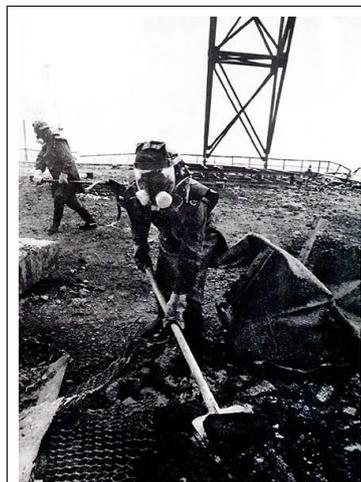
*Liquidateur déblayant le toit du réacteur n°3 des éléments du coeur éjectés lors de l'explosion.*
